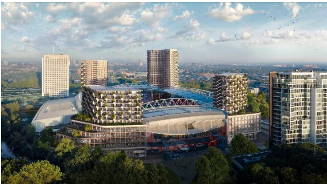
Impressie van het nieuwe stadiongebied. Beeld: MVSA-Galgenwaard development
