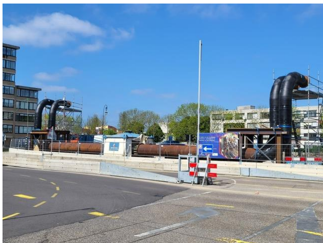
De warmtebuizen van Eneco steken hoog boven het bouwterrein uit
