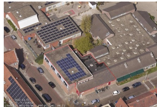
Bovenaanzicht gymzaal Zuilen
