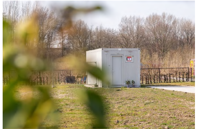
Eén van de 2 bestaande cabins
