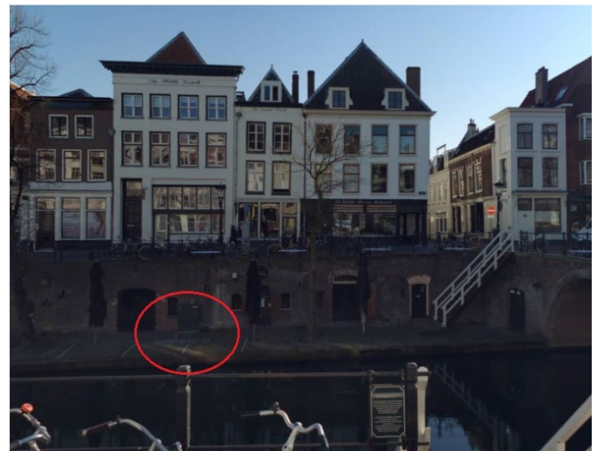
De rode cirkel markeert de plek van het rioolgemaal
